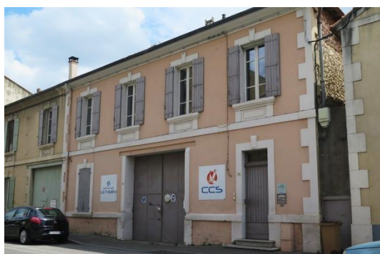
Ancienne maison d'expédition d'Emile Viens au quartier du Grenouillet.
