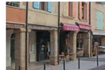
Alignement d'immeubles traditionnels de style régional
