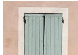
Détail de façade traditionnelle, encadrement peint et contrevent en bois peint
